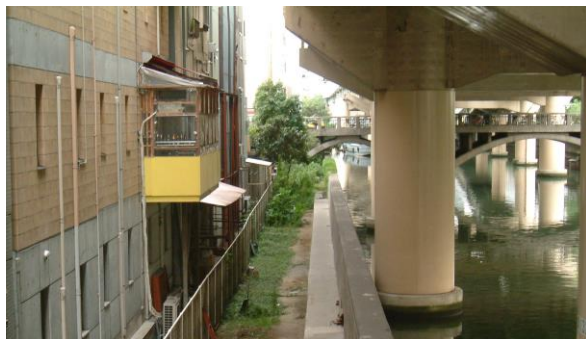
平成19年 川側にテラスを設けた飲食店
